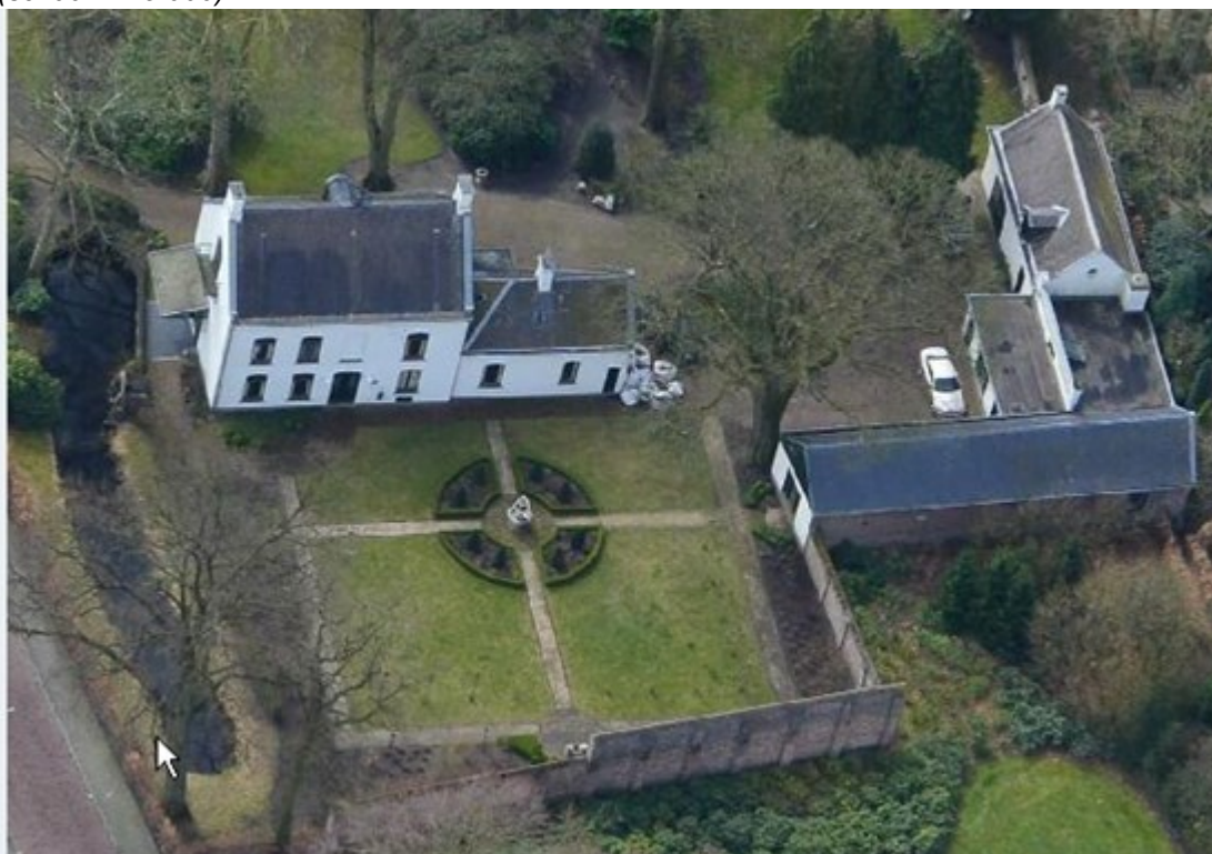
Het complex Agnetendal vanuit de lucht gezien.
