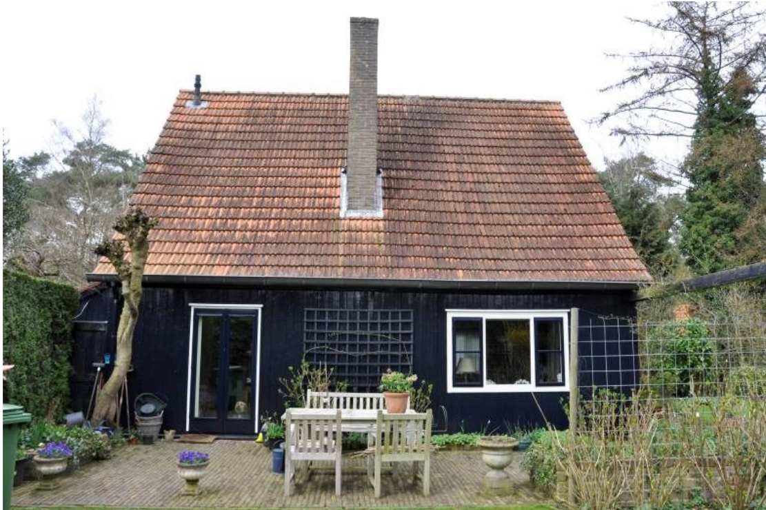
Achterzijde van een van de woningen aan de Merellaan (foto Bureau Hüsken en Zoon 2015).
