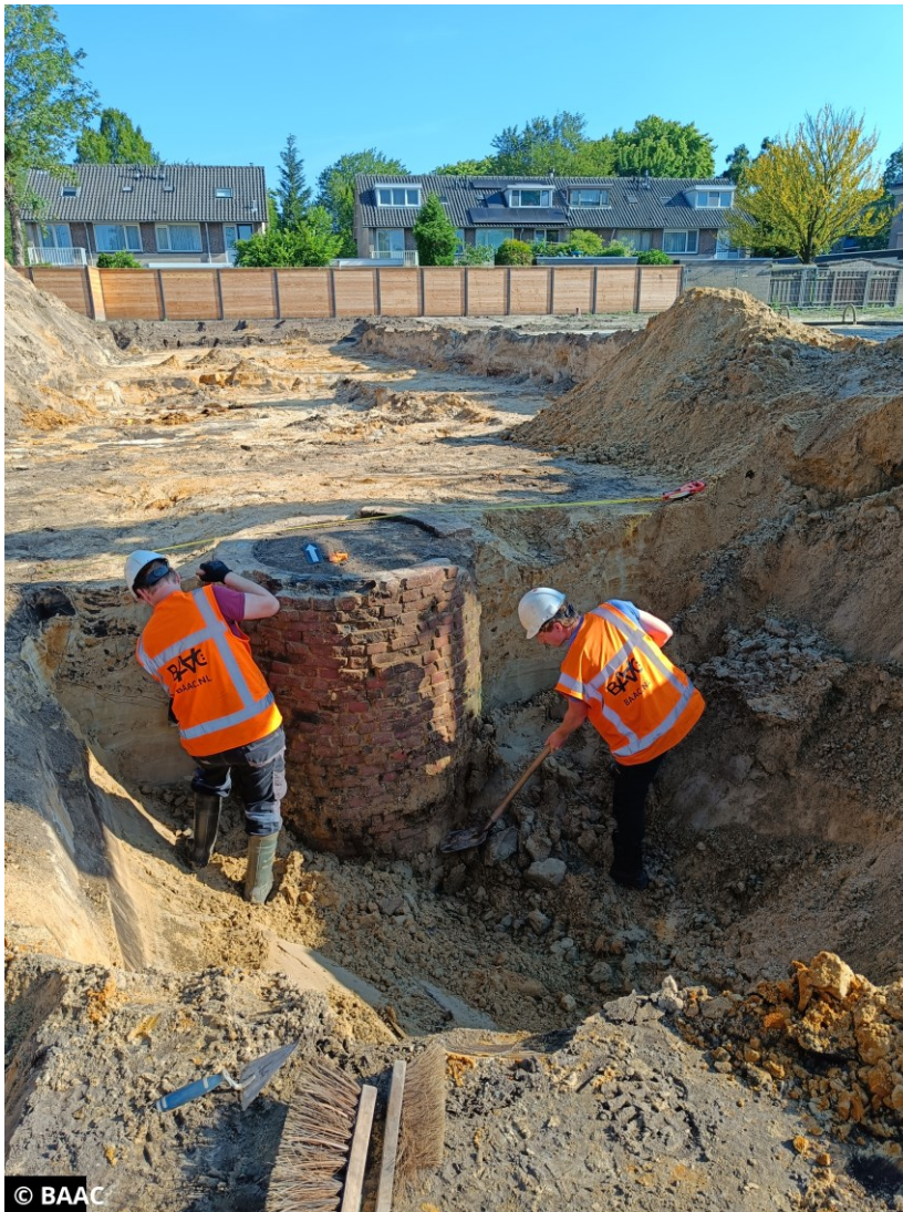
Opgraving van een bakstenen waterput uit begin 20 e eeuw bij de Wilde Wingerd in 2024 (foto BAAC).
